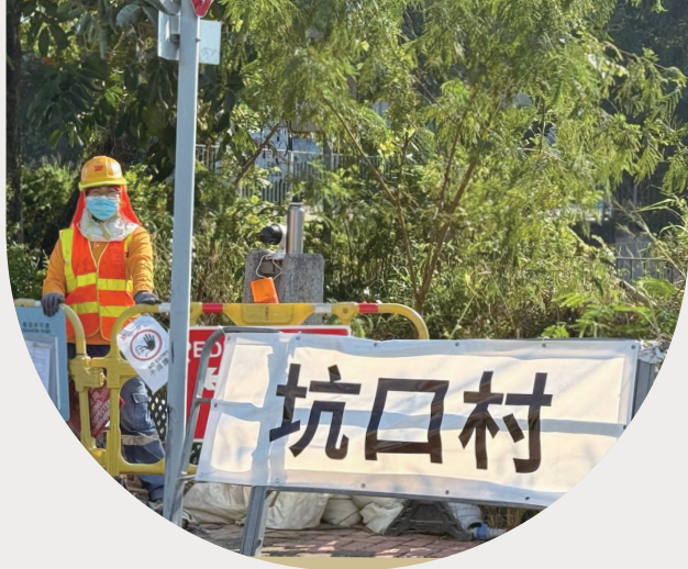
▲ 潤晉員工 Geeta 在元朗流浮山坑口村的工地
